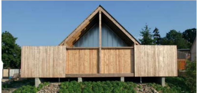
7/8/9 Ansicht vom Grimnitzsee bei geöffnetem Tor / Ansicht vom Grimnitzsee bei halb geöffnetem Tor / Ansicht vom Grimnitzsee bei geschlossenem Tor
